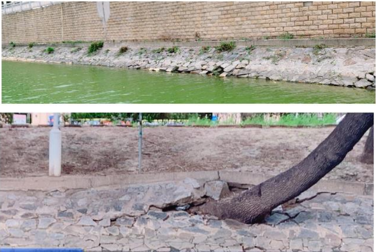
图 2-1 南运河清淤段岸线现状图
